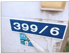
ป้ายแสดงเลขที่อาคาร
