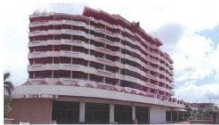
สภาพ และรูปทรง อาคาร โรงแรมสูง 10 ชั้น (รายการที่ 1) ก่อสร้างอยู่ภายในที่ดินทรัพย์สิน กลุ่มที่ 1
