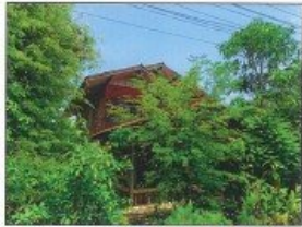
สภาพบ้านครึ่งตึกครึ่งไม้ 2 ชั้น เลขที่ 20 หมู่ 4 (รายการที่ 1)
