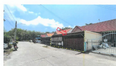
6. ภาพถ่ายที่บันทึกตำแหน่งที่ตั้งของทรัพย์สินในบริเวณนี้ / ถนนสุขุมวิท (Km. 3) แขวงบ้านสวน / เขตเมือง
