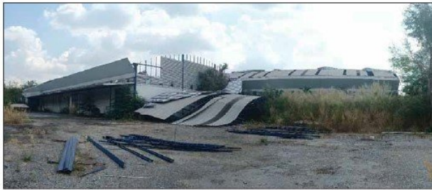
อาคารโรงงาน (อาคาร 1)
