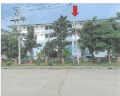
อาคารชุดตึกสิรานคร คอนโดมิเนียม อาคารเลขที่ 97 (อาคารซี) อาคารที่ตั้งทรัพย์สิน
